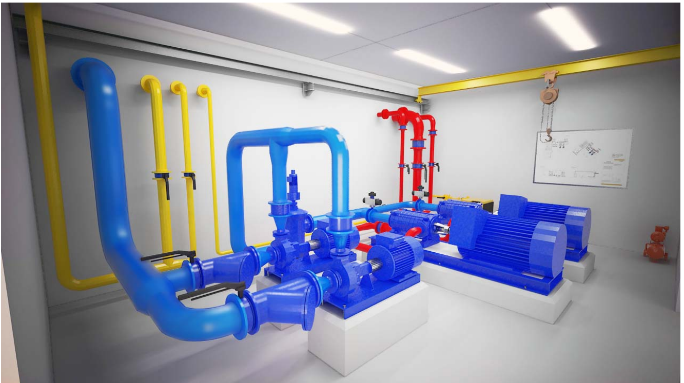
Pumpstation mit Vordruck- und Hochdruckpumpe
